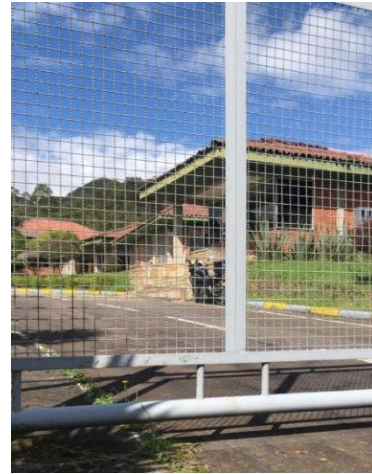
Fotografía 15: Fachada bodega Facatativá instalaciones de Ecopetrol
